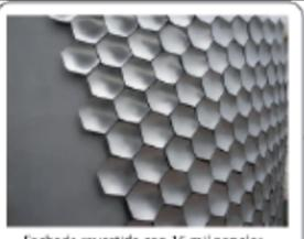
Fachada revestida con 16 mil paneles metálicos.
